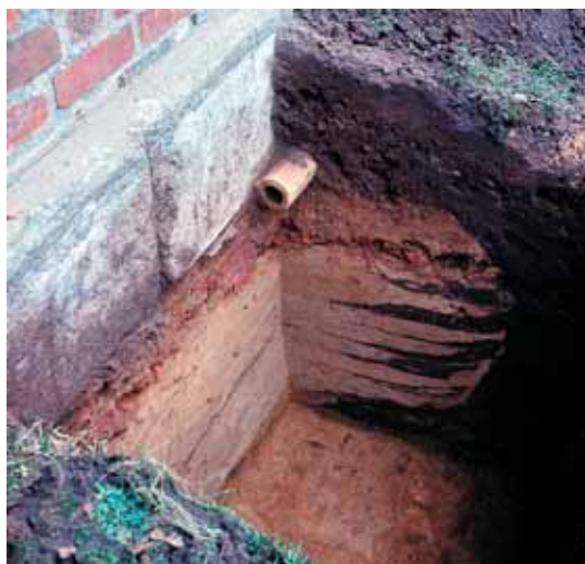
Fig. 5. Snit i fundament under nordre sideskib. Set fra ØNØ. Foto: NTS 1975.
