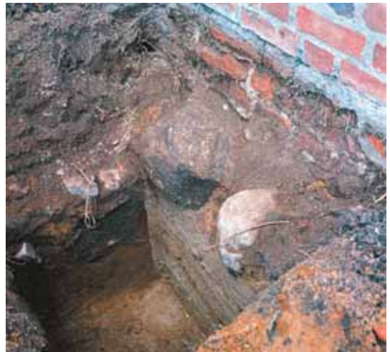
Fig. 4. Prøvegravning 1975 ved nordre sideskib. Over den vandret sribede fyld i fundamentgrøften ses kampesten og mur fra reetablering efter nedrivning (1817?) af et efterreformatorisk kapel. Foto: NTS.
