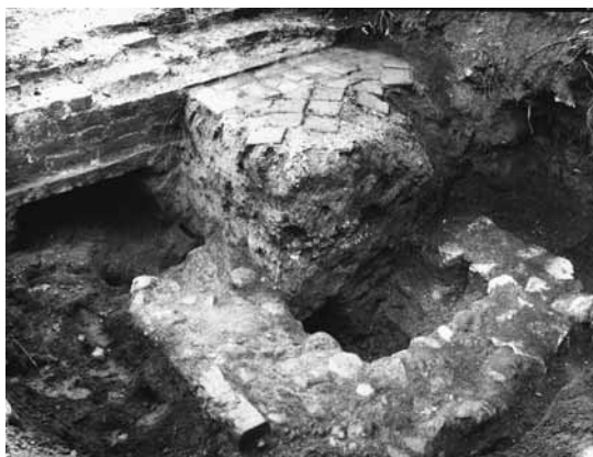
Fig. 28. Vestfløjens sydlige del. Under østmuren (tv.) ses intet stenfundament, hvilket tyder på tørvfundament. Den firkantede ramme af kampesten under gulvniveau er et efterreformatorisk anlæg med ukendt funktion. Set fra NV. Foto: Th. Møller 1914 (Städtisches Museum, Flensburg).
