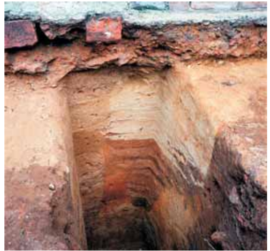
Fig. 14. Snit i fundament under søndre sideskibsmur. Fundamentets østafsnit ses th. med gule tørv øverst og brune tørv nederst. Vestafsnittet med gråbrune tørv ses tv. Mellem afsnittene ses urørt rødbrunt undergrundssand. Profilvæggen th. vises i fig. 15. Set fra S. Foto: NTS 1975.
