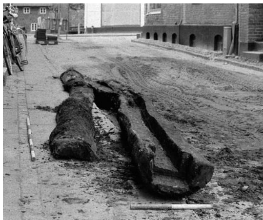
Fig. 6. Herover: En afløbsrende af træ fundet i forbindelse med gaderenovering i Sortebrødregade i sommeren 1991. Stammen er dendrokronologisk dateret til 1605-15. Foto: Sydvestjyske Museer.
