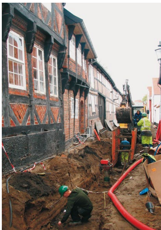
Fig. 3. Typisk udgravningssituation ud for Fiskergade 1. I grøftens profil ses sættelag af sand fra ældre stenbrolægninger. Foto: Sydvestjyske Museer.
