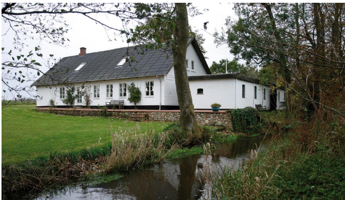
Fig. 10. Møllehuset. Møllehjulet fandtes umiddelbart ud for husets gavnl til Skallebækken.
