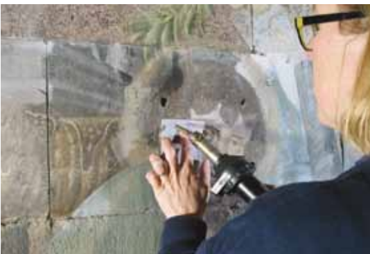
Fig. 15. Med en minivarmepistol opvarmes farvelag og lim en anelse og trykkes fast for at sikre en god vedhæftning til sandstenen.
