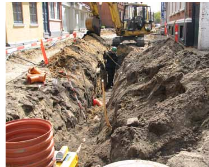
Fig. 4. Typisk udgravningssituation ud for Sct. Nicolaj Gade 4.
